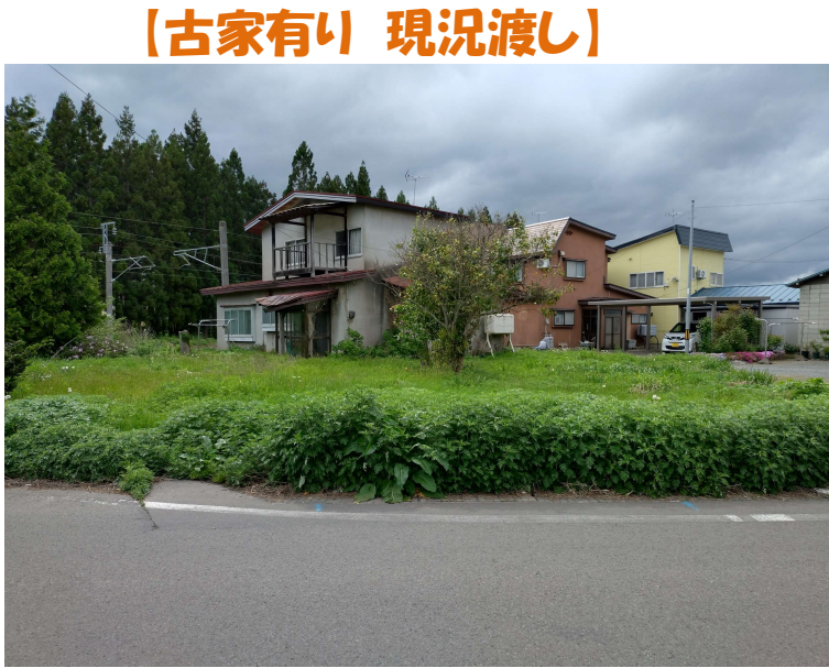
現地外観写真 現地(2025年6月)撮影
