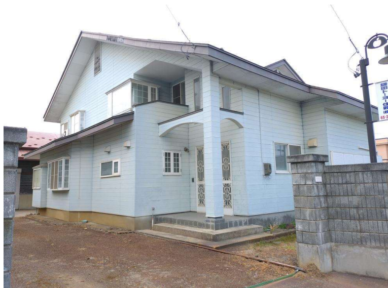
現地外観写真 現地(2025年6月)撮影
