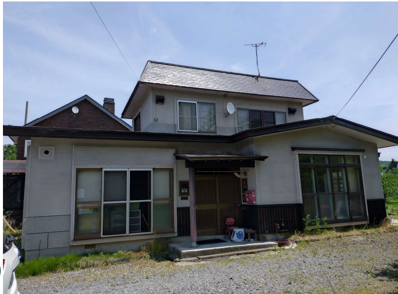
現地外観写真 現地(2025年3月)撮影 建物129.15㎡(39.06坪)
